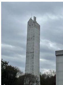
(クリーンセンター内から)
